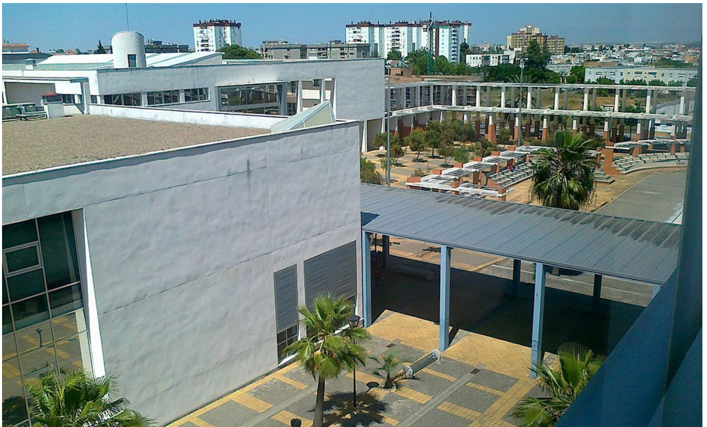
Campus de Jerez, vista desde el Espacio de aprendizaje de la Biblioteca del Campus. Andalucía (España)
